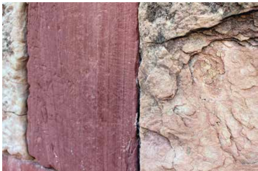
Detalle de la piedra en sillería de cantera moliz.
