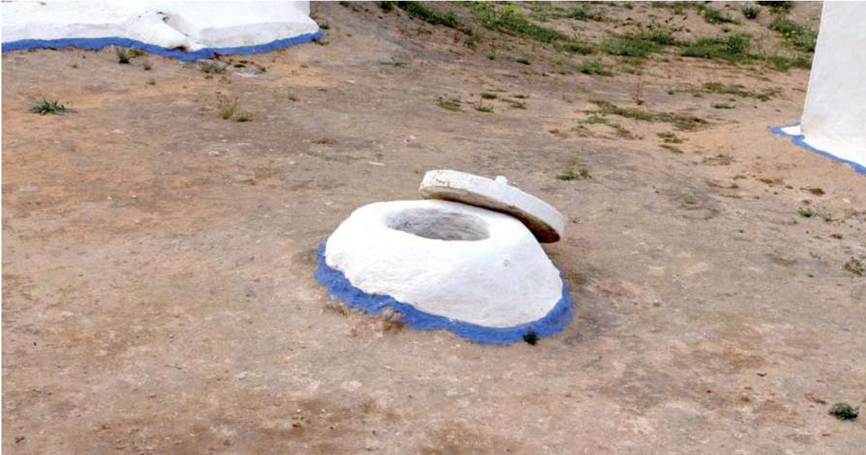
Respiraderos que sirven de ventilación interior para los silos
